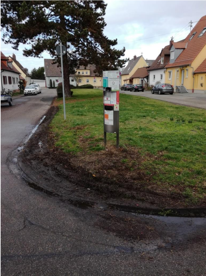
Ginsterplatz SW-Ecke: kein Bordstein mehr erkennbar
